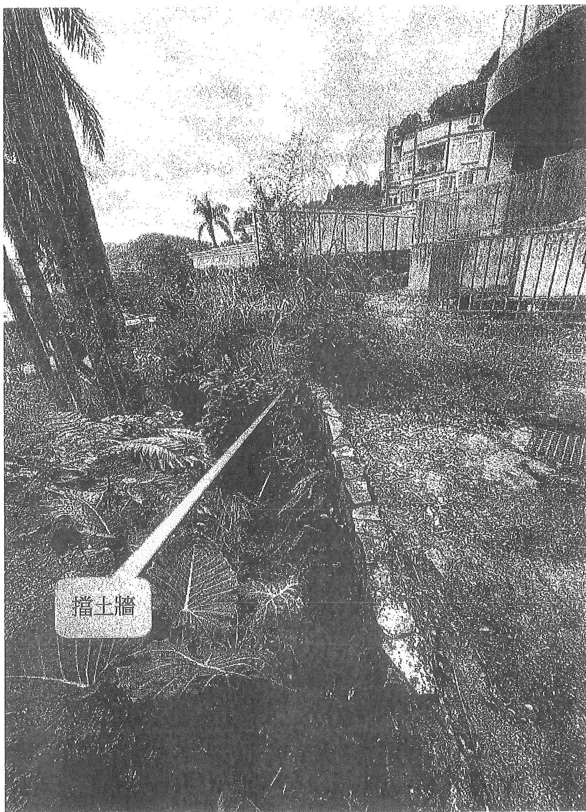
附件三、地號信義區吳興段三小段 42-1 之部分區域於擋土矮牆 下方四米處照片
